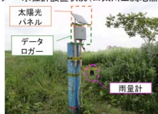
写真5. データロガー・太陽光パネル・雨量計設置状況(岩沼観測所地点)
